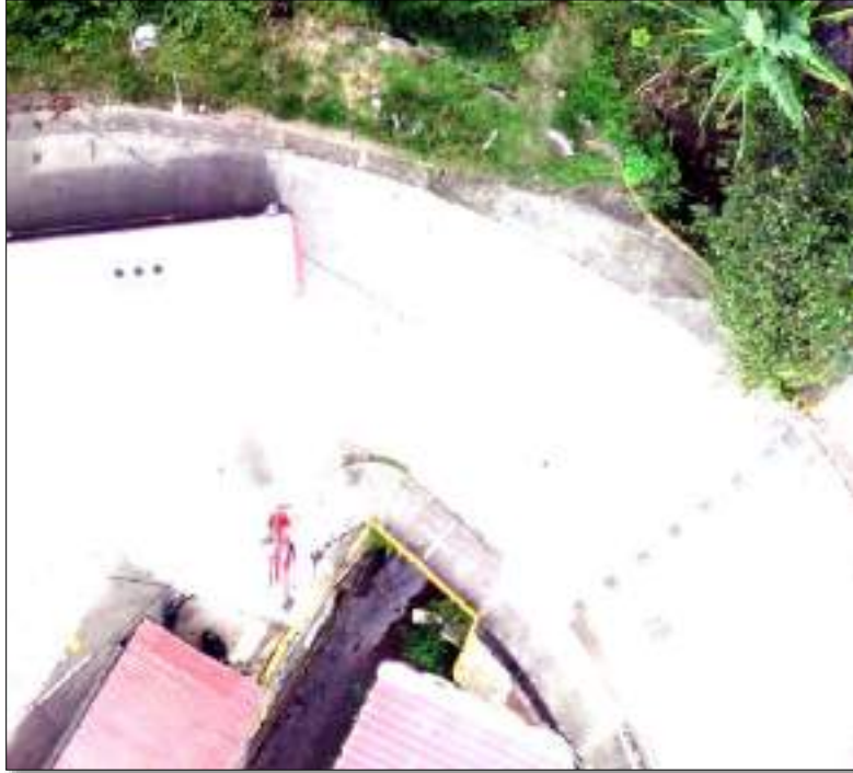
PUENTE SOBRE QUEBRADA LOS VENADOS Norte: 2318723; Este: 4955026
