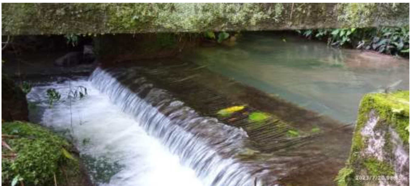
ILUSTRACIÓN 14 SISTEMA DE CAPTACION AFLORAMIENTO EL BORBOS
