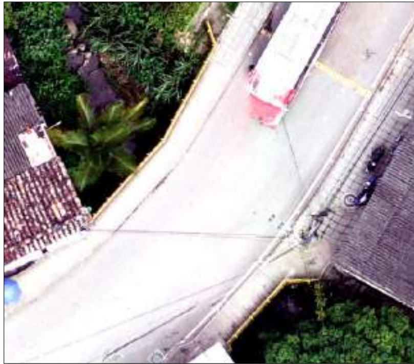
PUENTE CALLE 15 SECTOR LA FERIA Norte: 2317966; Este: 4954532.
