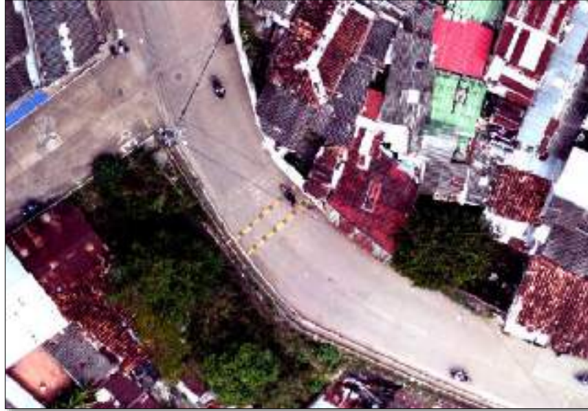
PUENTE CALLE 13 Norte: 2318175; Este: 4954501.
